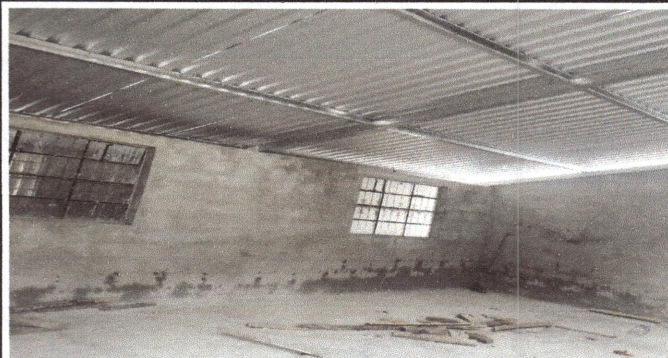
Foto 8: aplicación de cernido y cambio de estructura de techo y laminas de aulas en módulo 1
