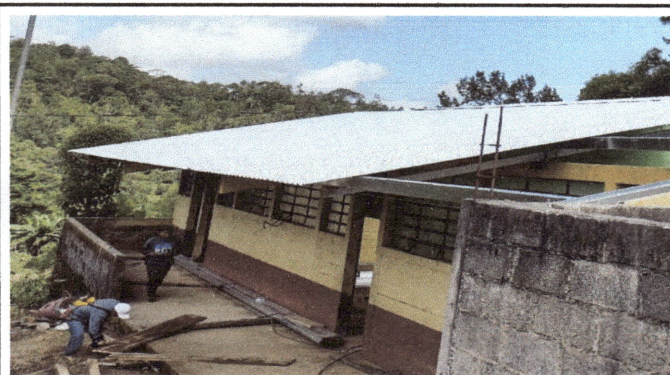
Foto 3: Modulo 2 laminas y estructura nueva siendo instaladas
