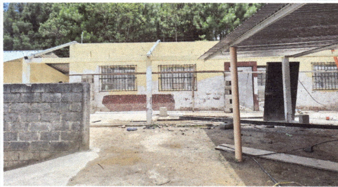
Foto 1: Laminas del modulo 1 en proceso de susutitución y paredes en proceso de rehabilitación
