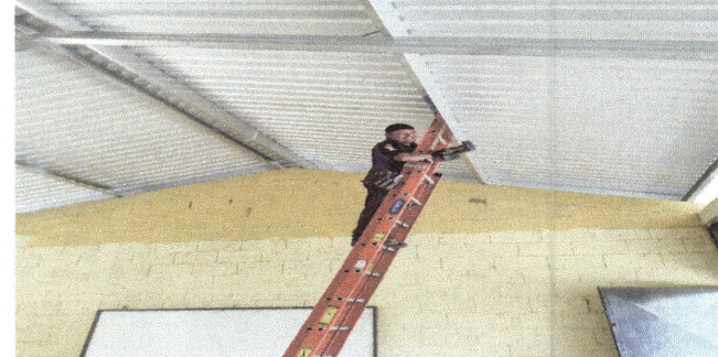
Foto 12: proceso de instalación de sistema eléctrico
