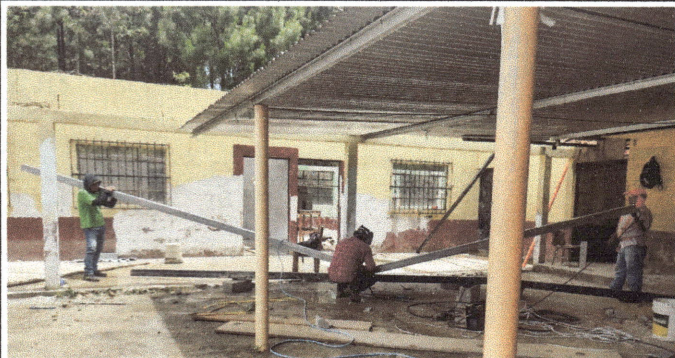
Foto 7: trabajos de sustitución de laminas y estructura de techo de aulas módulo 1
