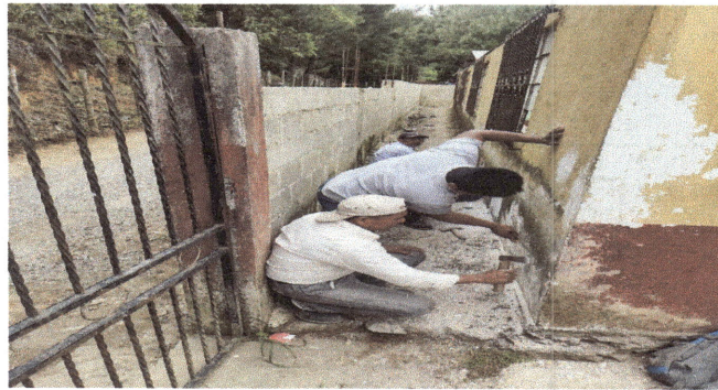
Foto 10: aplicación de cernido en paredes exteriores de módulo 1
