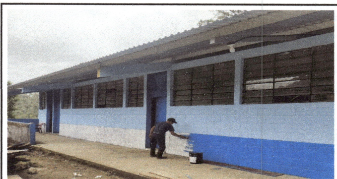
Foto 6: aplicación de pintura nueva en módulo 2
